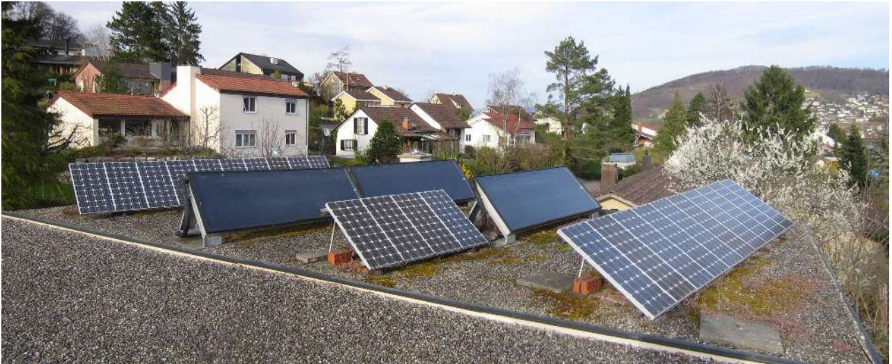
Abbildung 1: Diese Solaranlage in Frenkendorf ist genau nach Süden aufgestellt obwohl die Hausfront nach Südsüdosten zeigt.
