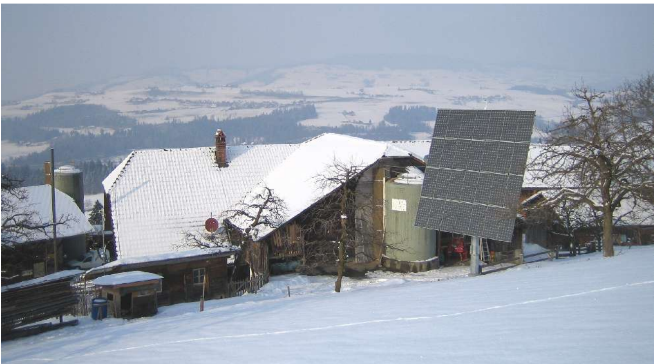
Abbildung 2: Diese Solaranlage in Schwendibach bei Homberg zeigt immer rechtwinklig zur Sonne.
